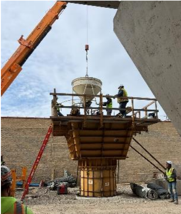
Column Concrete Pour
