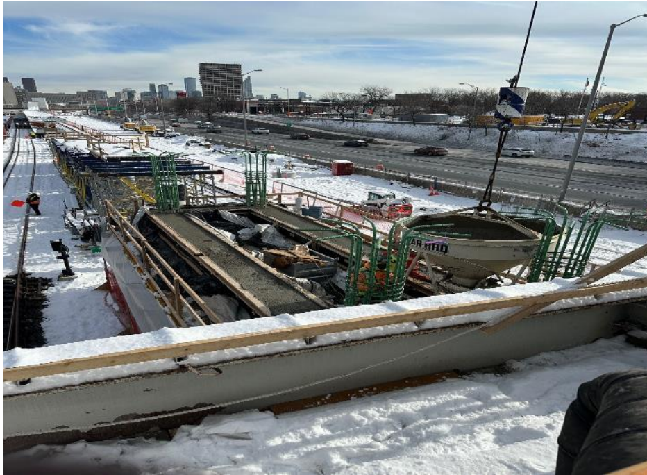
Loomis Stationhouse Beams Concrete Pour
