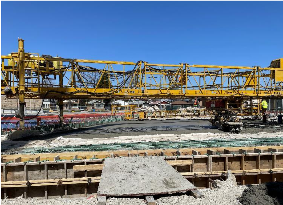
Close View of Bridge Deck Pour
